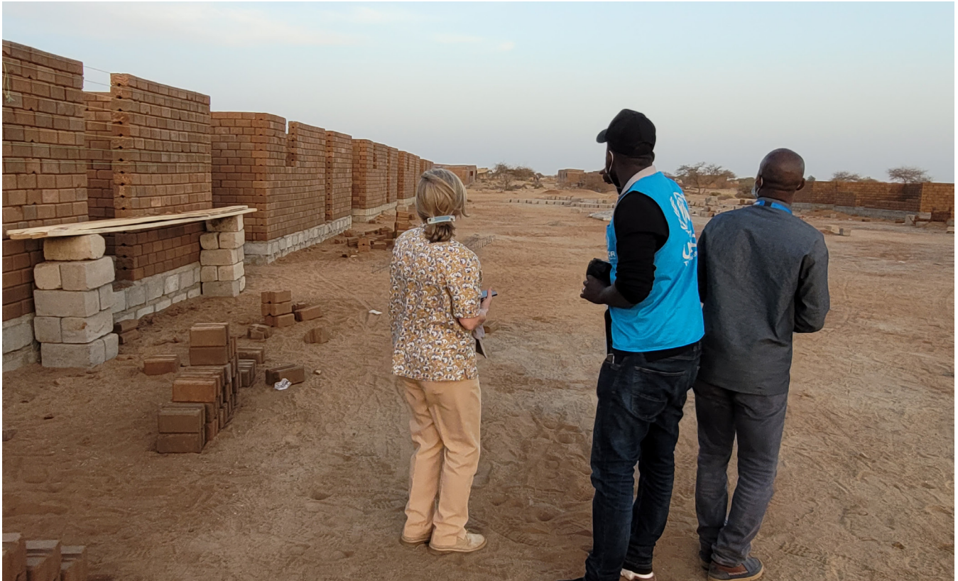
MALI/ GAO : Site de transit de PDI en construction.
